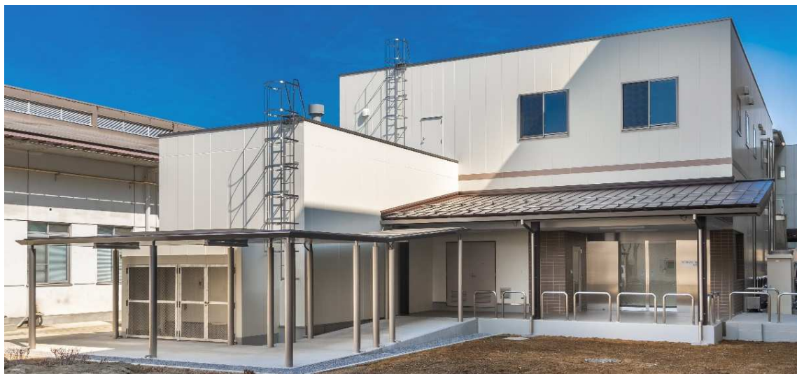
3Dデジタル生産技術共同研究棟
