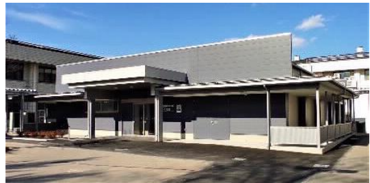
次世代高速通信モジュール評価試験棟(新棟)
