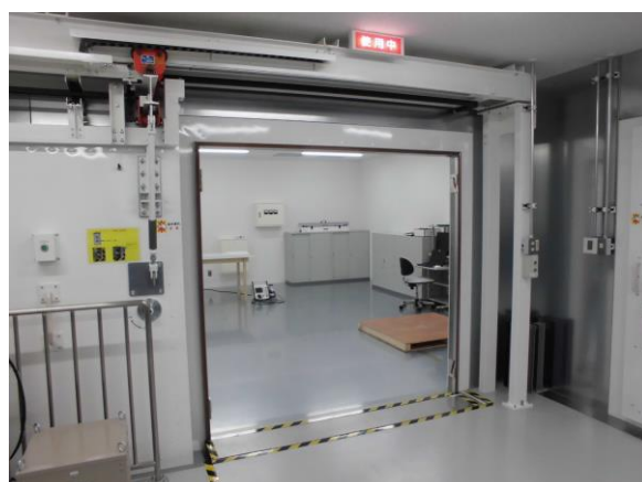
図2 シールドルーム入口
